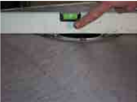
10. Şapın üstünde düz fayanslamaya elverişli bir boşluk oluşuyor
