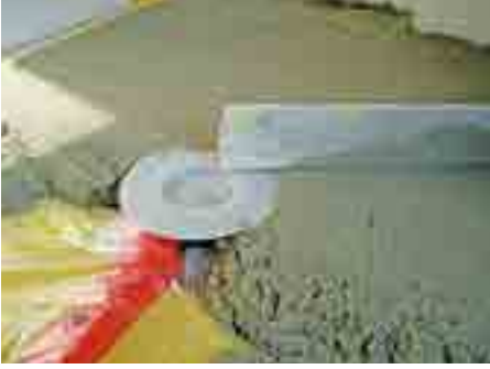
1. Şapı döküp, yapı korumasının üzerinden eğimli düzleyin
